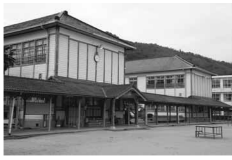
西脇小学校木造校舎の保存改修に向けて実施設計を行います
