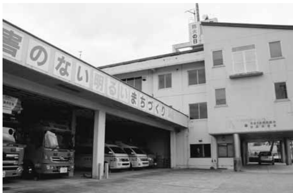
西脇消防署（写真）の耐震・増築工事を実施し、併せて津万地区に出張所を新設します
