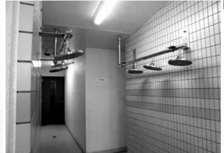
リニューアルした温水プールとシャワー室
