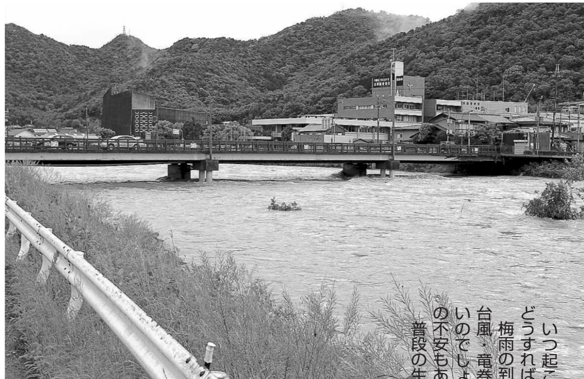
▲降雨により増水した杉原川（三和橋付近）
