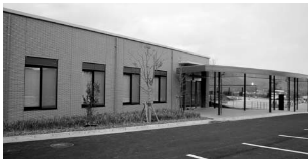
▲増設部分の外観
