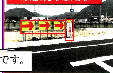
「一方通行」仮設看板
