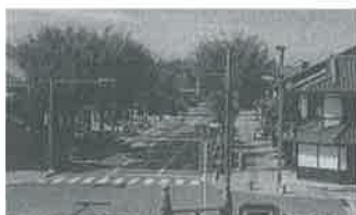
整備後の様子
