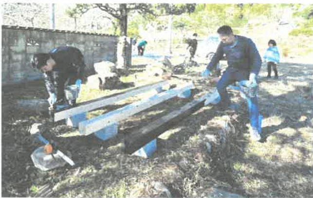
第3回目 ウッドデッキづくり
