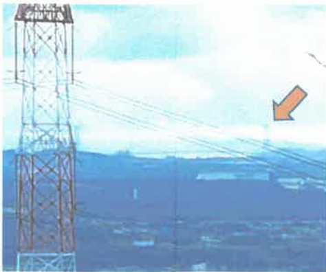
明石海峡大橋の主塔
