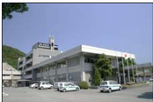
▲西脇市役所庁舎
