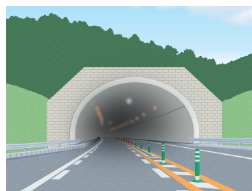
国道175号と国道427号をつなぐトンネル
