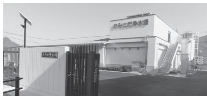
上戸田浄水場
