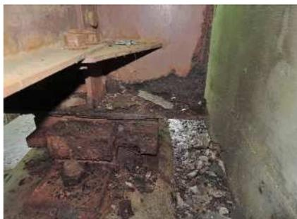
主桁に腐食が見られます
