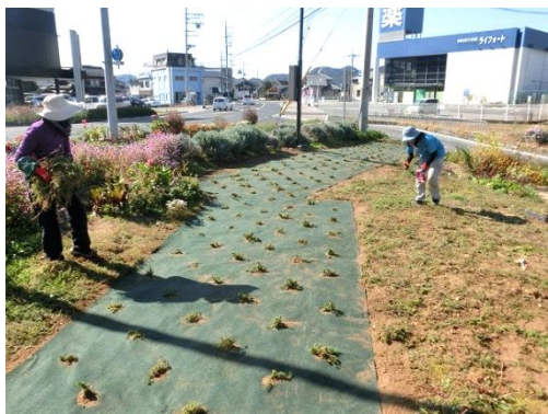
防草シート設置例（しばざくらの丘）
