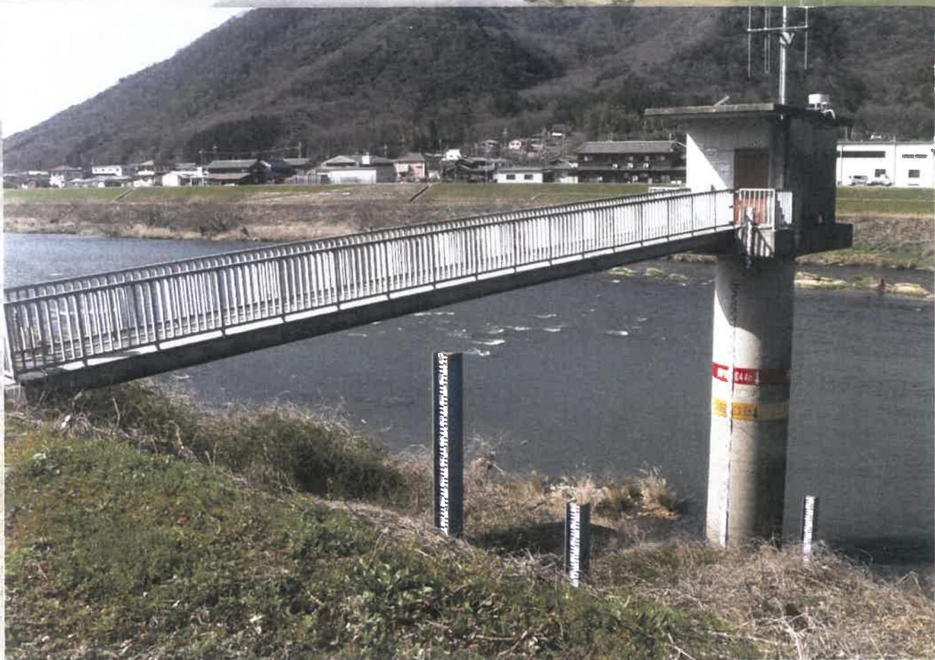
兵庫県第1の大河「加古川」、その中流域の水位を測定し、送信する施設として「板波水位流量観測所」が東岸の高松町地内に所在している。ここは、加古川の上流部の2つの流域部分（佐治地域・丹波篠山地域）と、その他の中小河川が1つになって流下する加古川本流の中間要所の場所にあたる。
