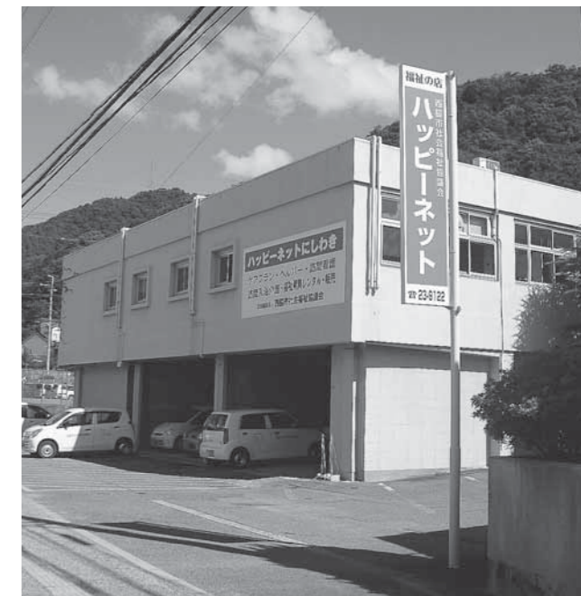
▲学童保育室を設置したハッピーネット西脇
