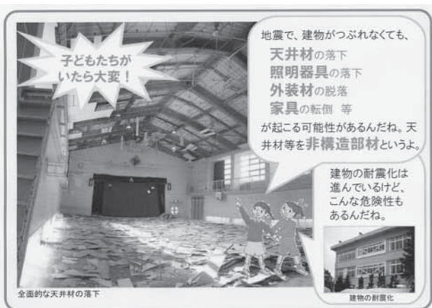
▲学校施設の非構造部材の耐震化
