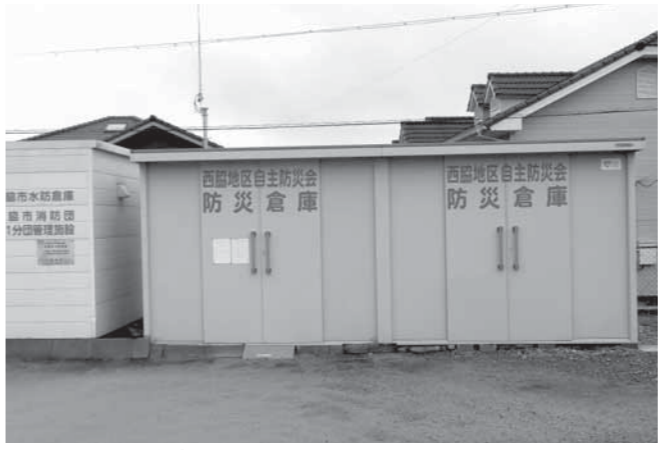
▲西脇地区防災倉庫
