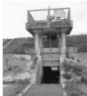
福地地区樋門
