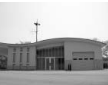
黒田庄防災ステーション
