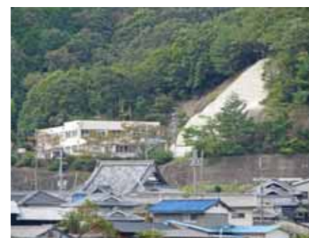
急傾斜警戒区域に隣接する芳田の里ふれあい館
