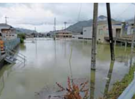
7月豪雨での黒田庄町田高の浸水現場
