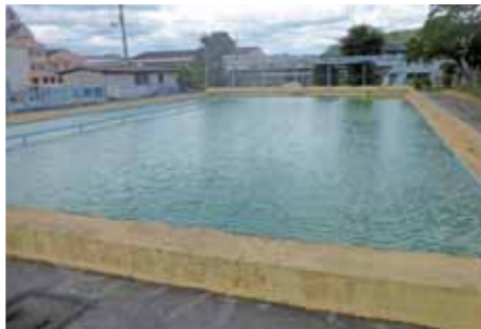
改修が待たれる比延小学校プール
