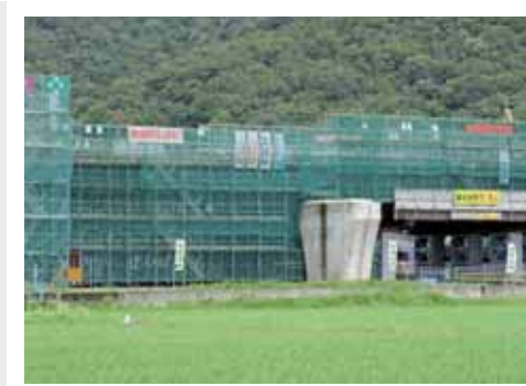
着々と工事が進む西脇北バイパス
